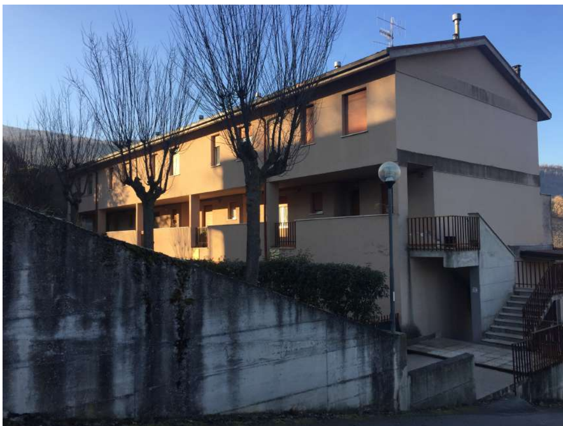
Vista posteriore dell'edificio
